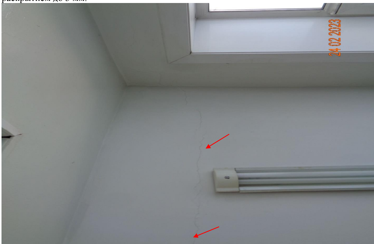
Фото 24. 1 этаж. Оси В/5. Трещина с раскрытием до 0,5 мм.
