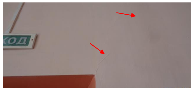
Фото 33. 1 этаж. Ось «А». Трещина с раскрытием 0,3 мм.
