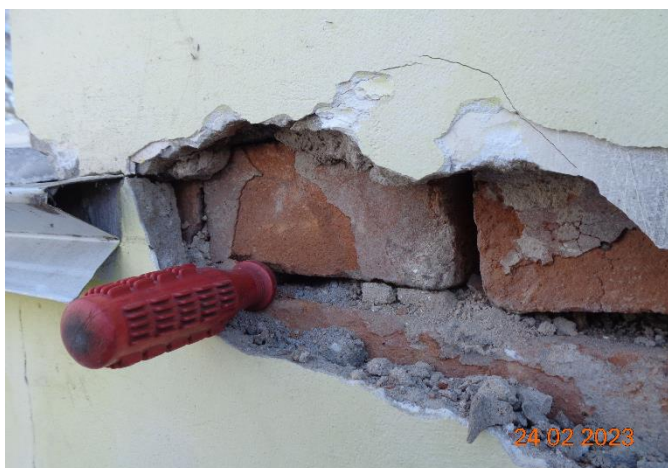
Фото 5. Ось «В». Трещины с раскрытием до 2 мм. Вскрытие на фото 37.
