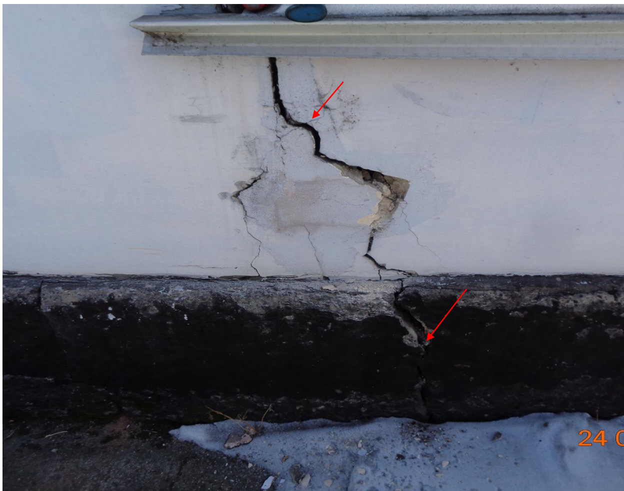
Фото 11. Ось «8». До вскрытия. Трещины с раскрытием до 5 мм.
