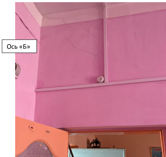
Фото 34. Трещины на стене по оси «Б» в верхних углах на втором этаже.
