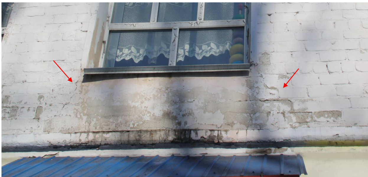
Фото 16. Ось «А». Трещины с раскрытием 0,5 мм.
