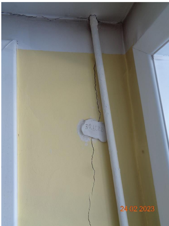
Фото 22. 1 этаж. Оси В/1. Трещина с раскрытием до 3 мм.
