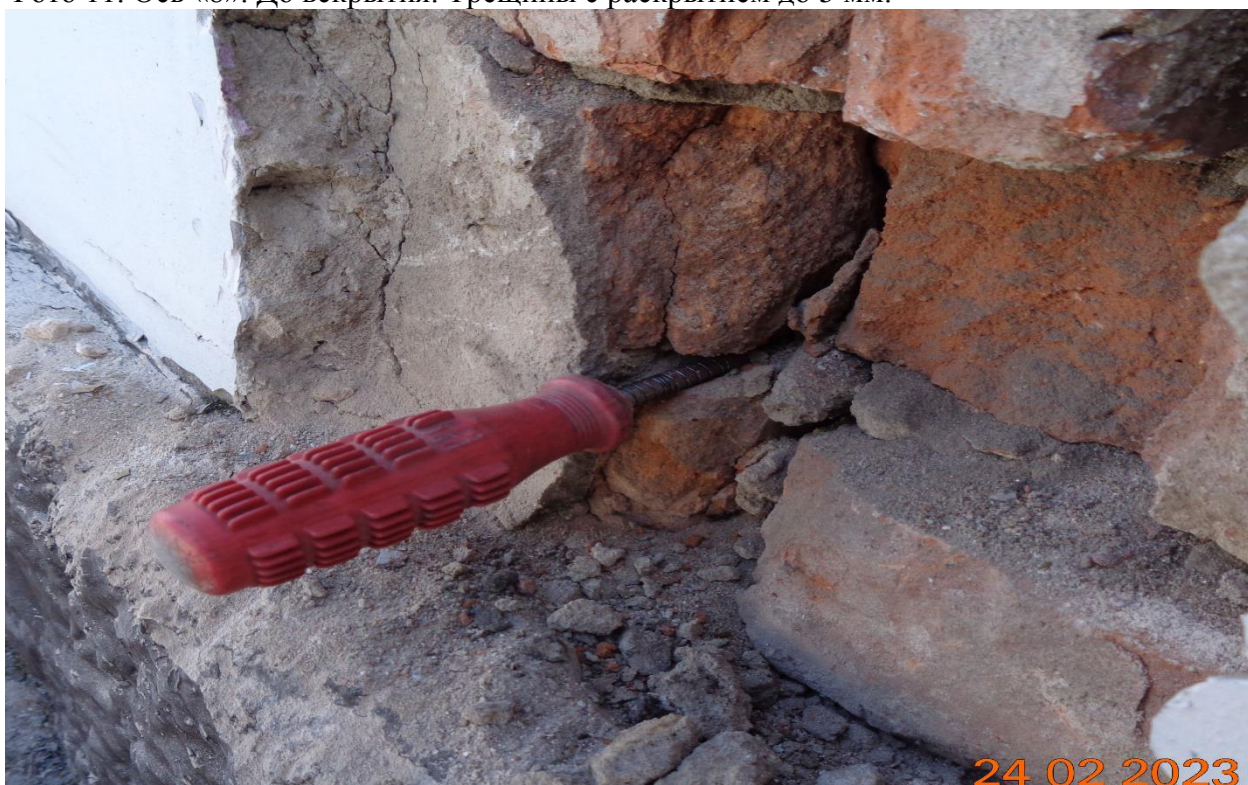
Фото 12. Ось «8». После вскрытия( См. фото 11). Щуп без особых усилий проникает в горизонтальный шов на 150 мм.
