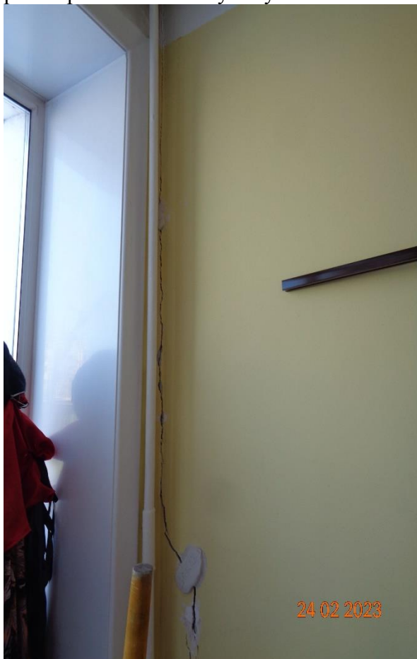
Фото 20. 1 этаж. Оси В/2. Трещина с раскрытием до 10 мм.
