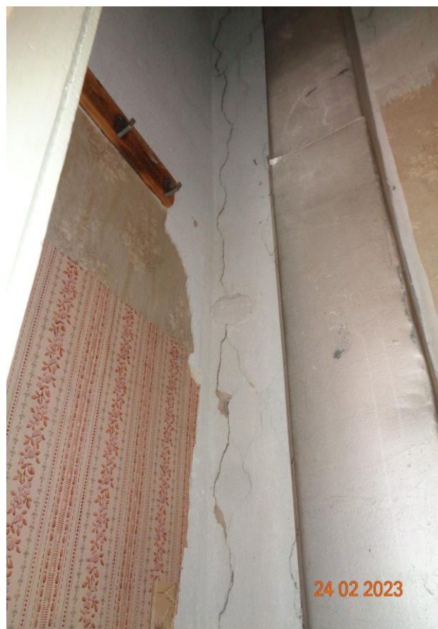
Фото 30. 2 этаж. Оси Б/2/В/3. Трещина в перегородке.
