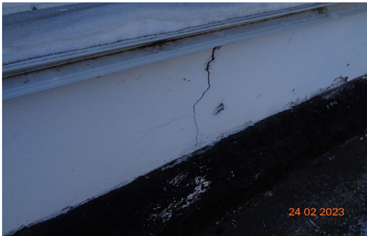
Фото 9. Ось «В». Трещины с раскрытием до 3 мм.
