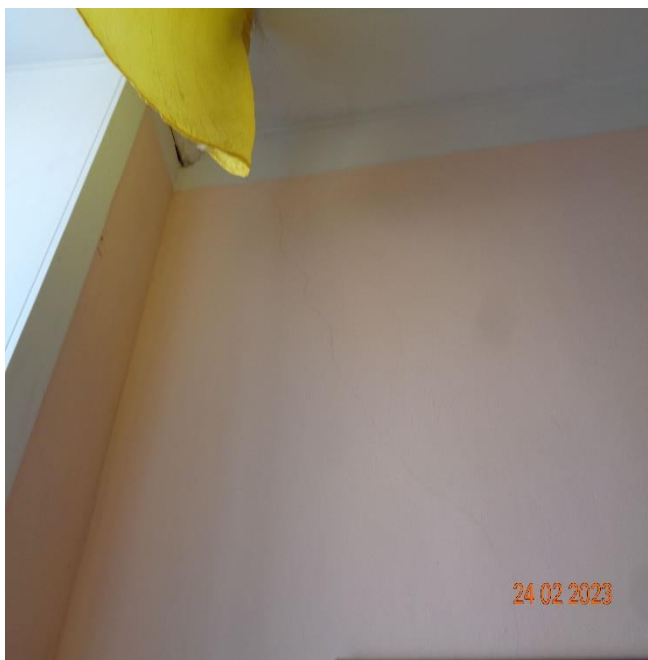
Фото 25. 2 этаж. Оси В/5. Трещина с раскрытием до 1 мм.
