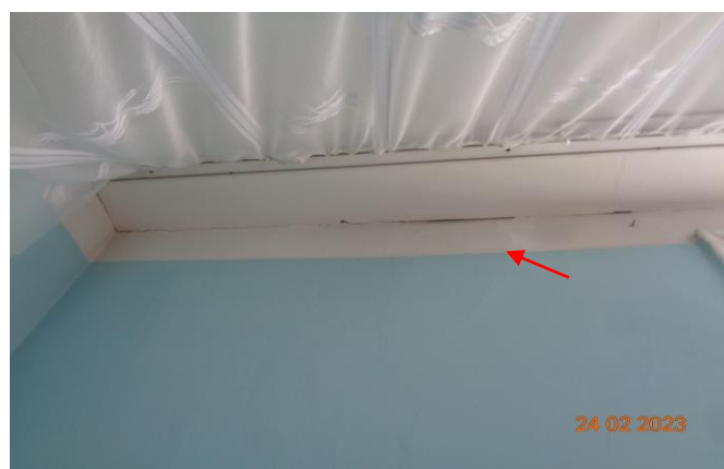
Фото 32-844. 1 этаж. Оси В/1. Трещина с раскрытием 0,5 мм.
