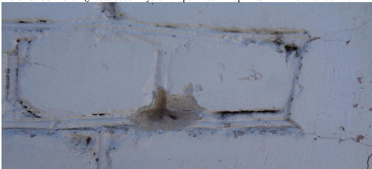
Фото 14. Ось «8». Уровень второго этажа. Щуп без особых усилий проникает в горизонтальный шов на 150 мм.
