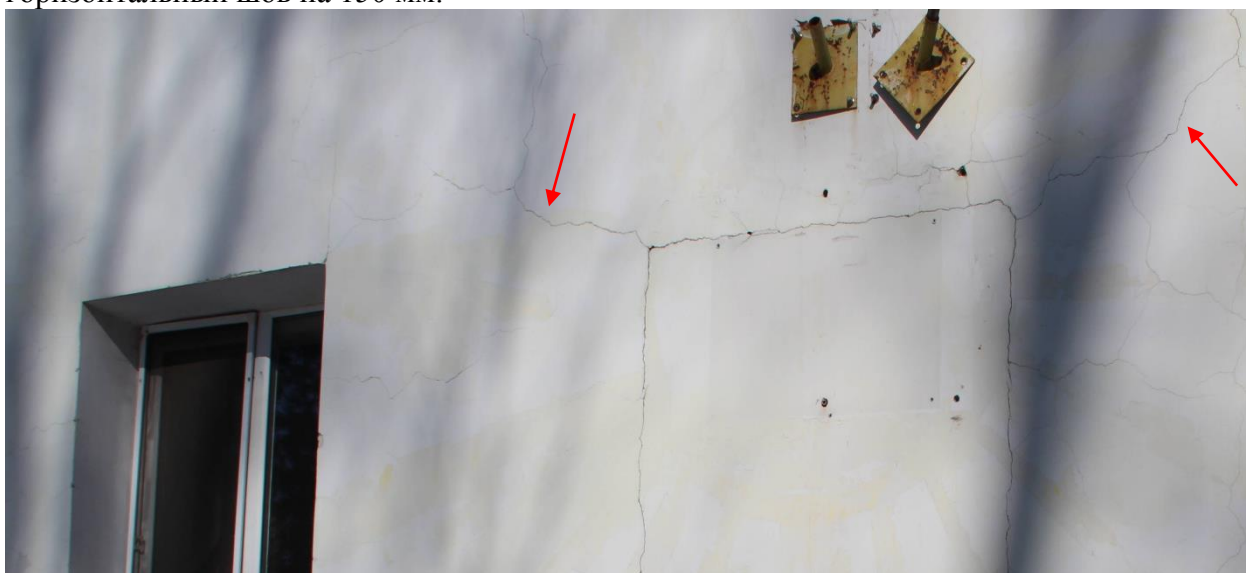
Фото 15. Ось «А». Трещины с раскрытием 0,5 мм.
