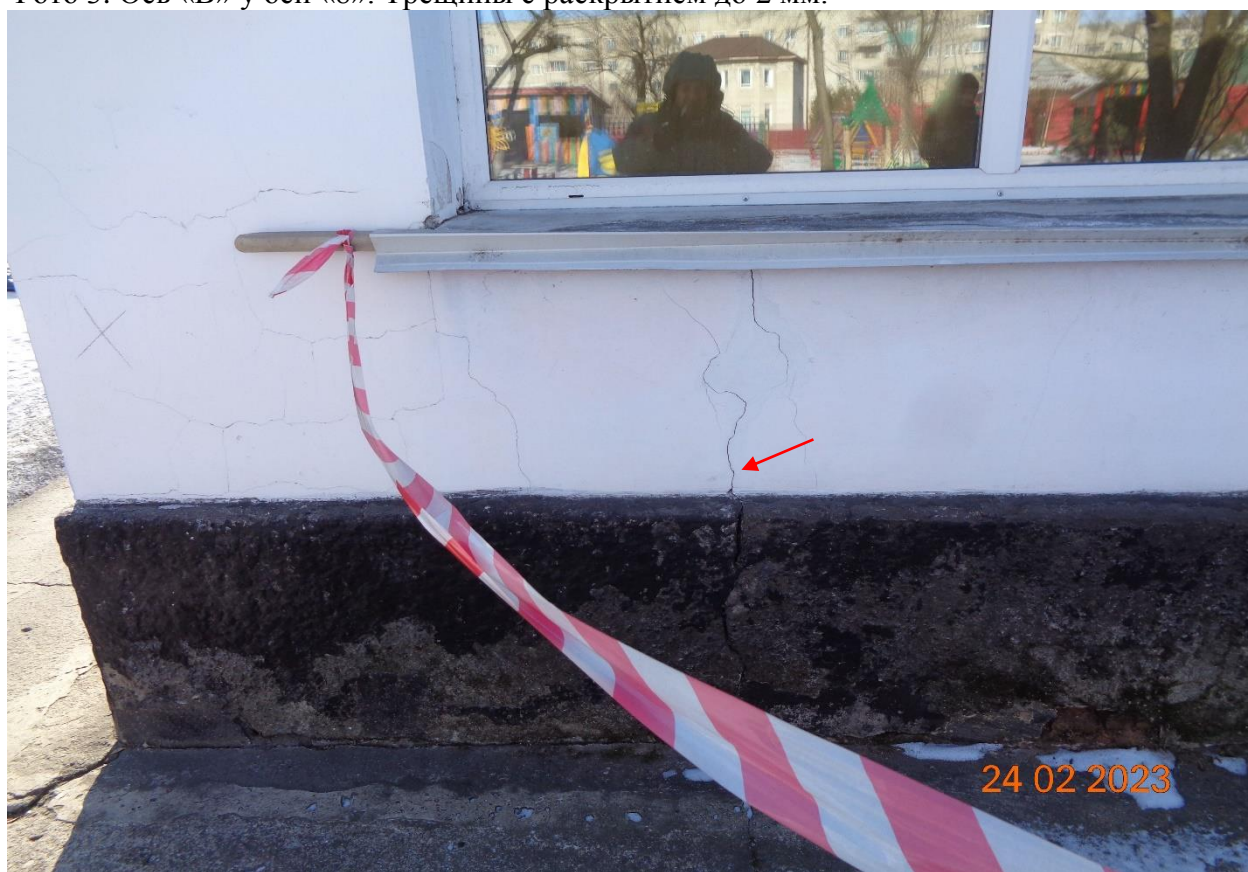
Фото 4. Ось «В» у оси «8». Трещины с раскрытием до 2 мм.
