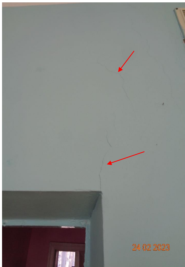
Фото 29. 1 этаж. Оси В/1. Трещина с раскрытием до 1 мм.
