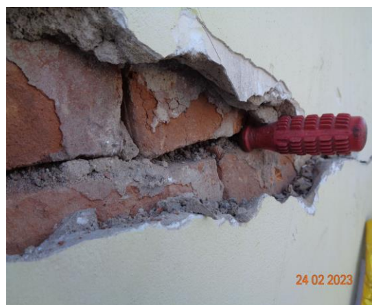
Фото 6. Ось «В». Вскрытие трещины. Раствор имеет очень низкую прочность, раскрошен. Щуп при незначительных усилиях проникает в раствор на глубину до 150 мм.
