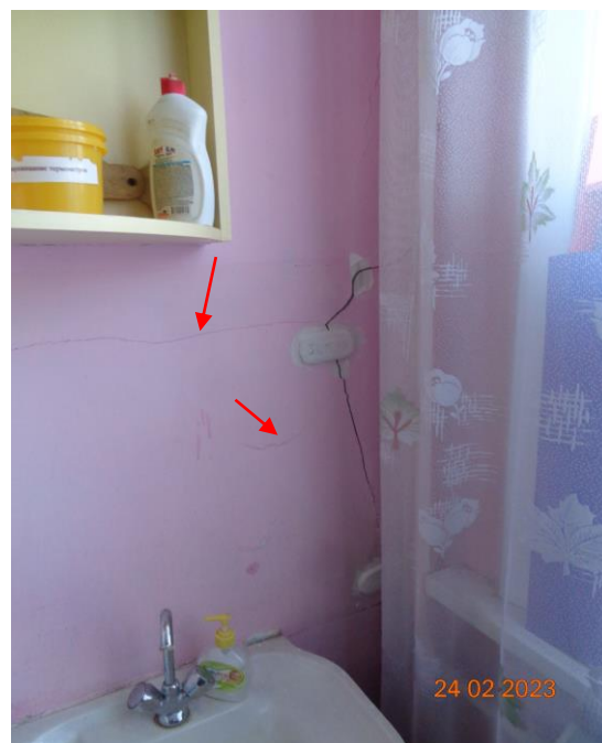
Фото 23. 1 этаж. Оси В/2. Трещина с раскрытием до 10 мм.
