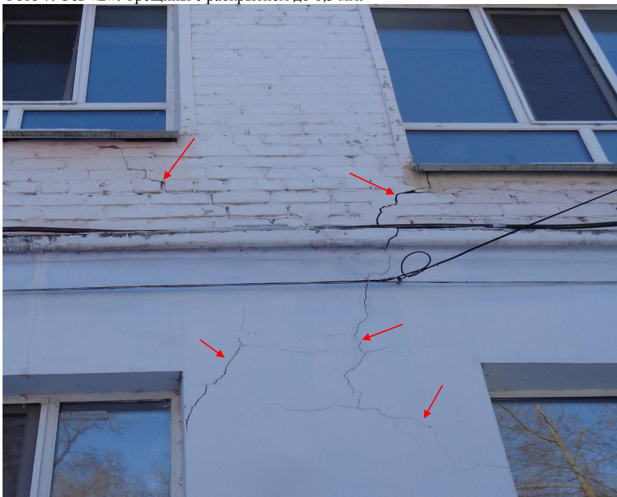
Фото 8. Ось «В». Трещины с раскрытием до 5 мм.
