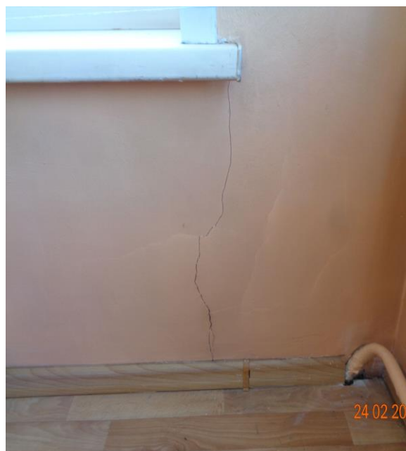
Фото 26. 2 этаж. Оси В/1. Трещина с раскрытием до 1,5 мм
