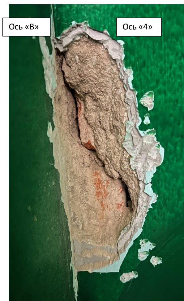
Фото 36. Первый этаж. Вскрытие сопряжения стен по осям «В»-«4». Трещина.
