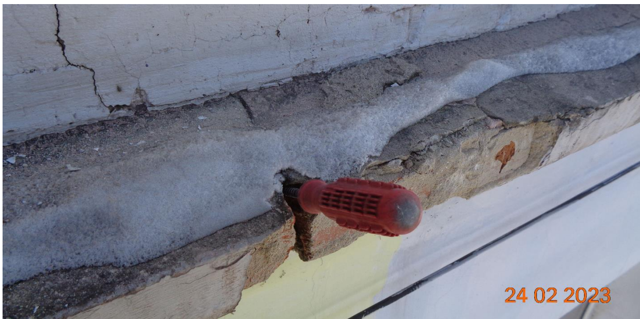
Фото 13. Ось «8». Щуп без особых усилий проникает в вертикальный шов на 150 мм.
