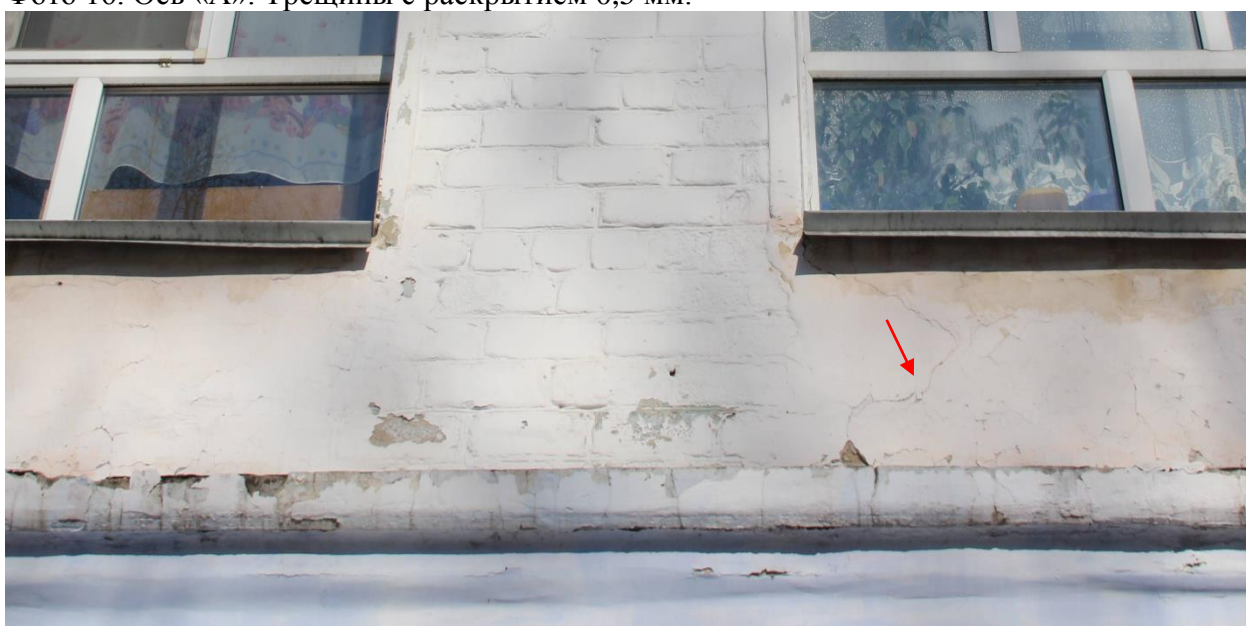
Фото 17. Ось «А». Трещины с раскрытием 0,5 мм.
