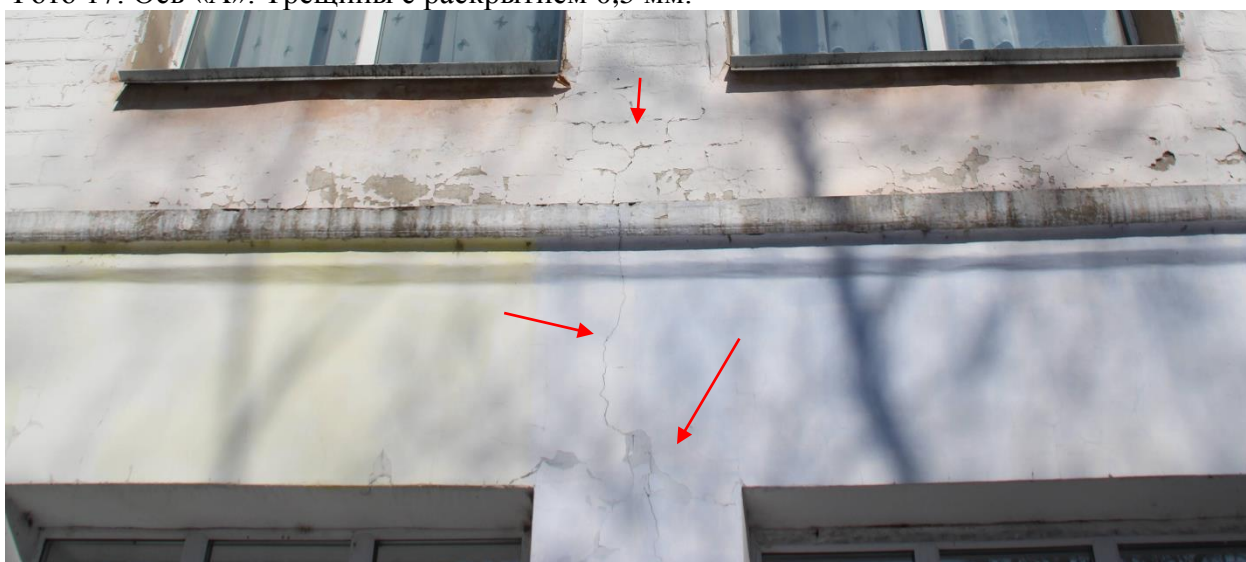
Фото 18. Ось «А». Трещины с раскрытием 1,5 мм.
