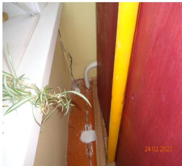
Фото 21. 1 этаж. Оси В/2. Трещина с раскрытием до 10 мм.
