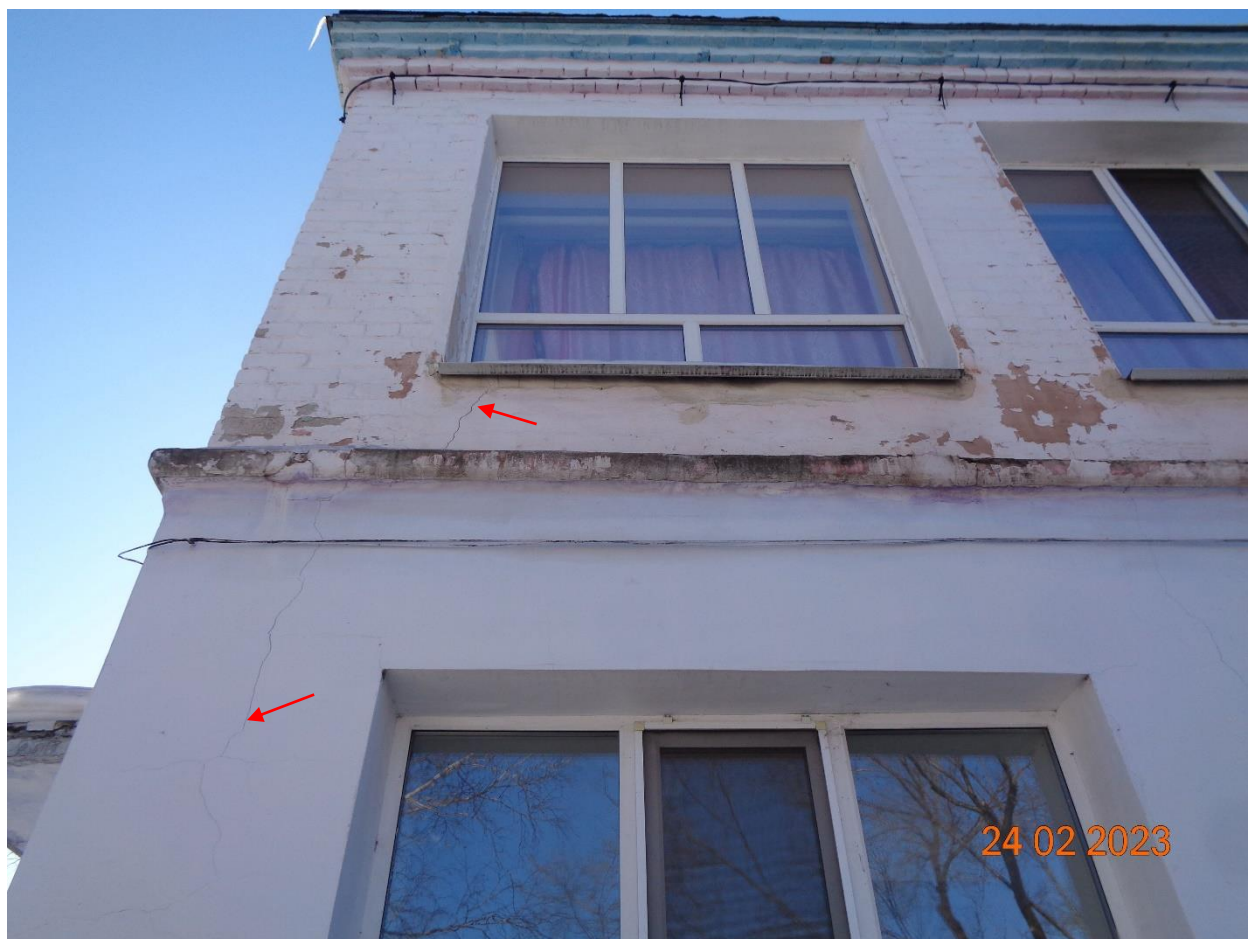
Фото 3. Ось «В» у оси «8». Трещины с раскрытием до 2 мм.
