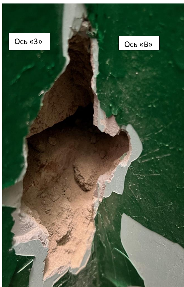
Фото 35. Первый этаж. Вскрытие сопряжения стен по осям «В»-«3». Низкая прочность раствора.
