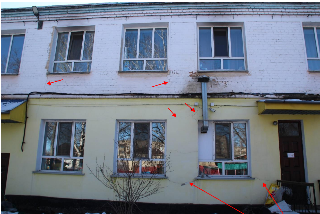
Фото 5. Ось «В». Трещины с раскрытием до 2 мм. Вскрытие на фото 37.
