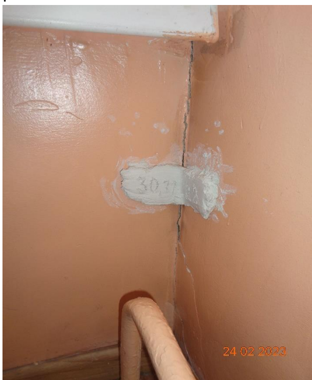
Фото 27. 2 этаж. Оси В/1. Трещина с раскрытием до 1 мм.
