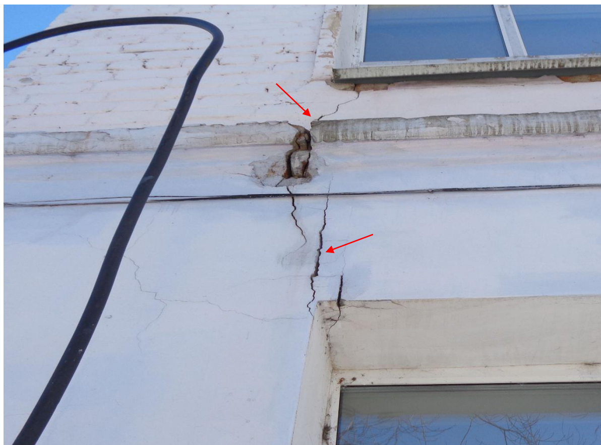
Фото 10. Ось «8». Трещины с раскрытием до 5 мм.
