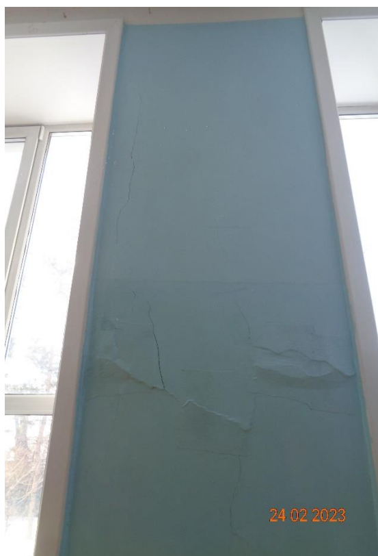
Фото 31. 1 этаж. Ось «А». Трещина с раскрытием 1 мм.
