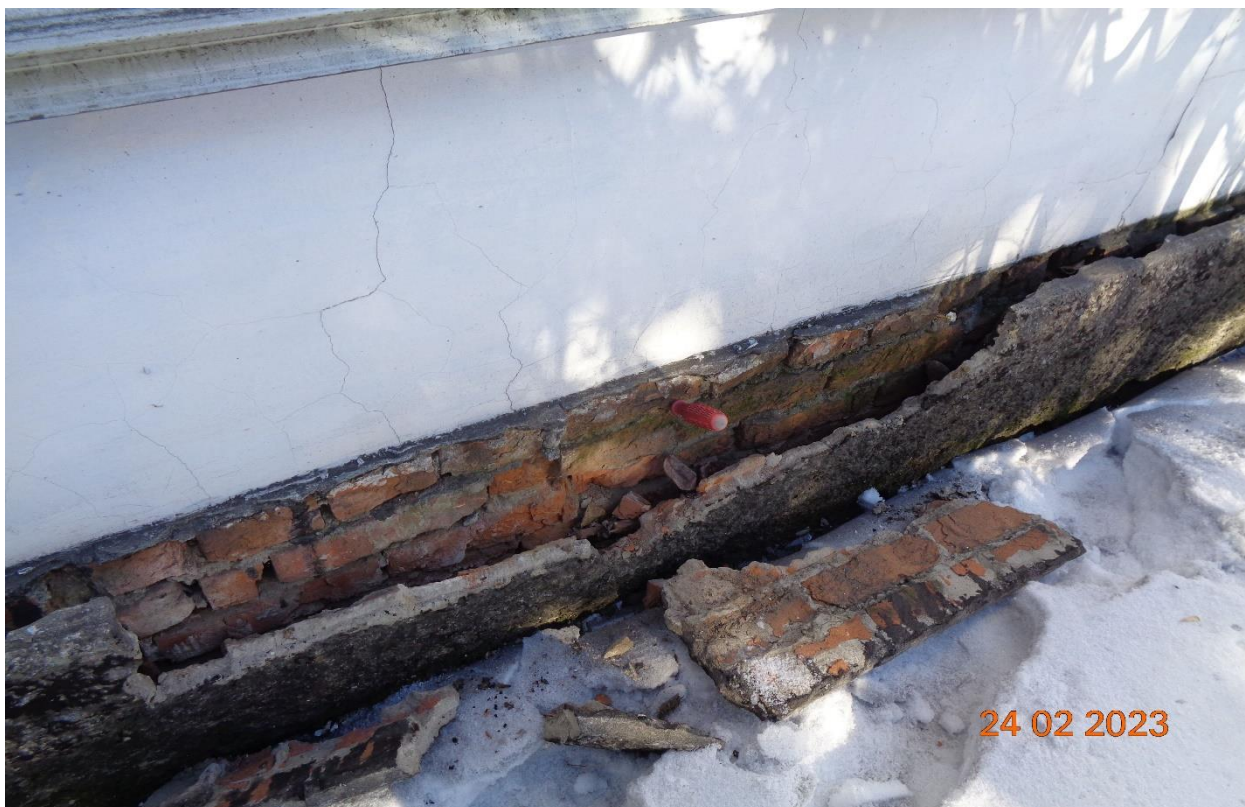
Фото 19. Ось «А». Трещины с раскрытием 0,5 мм. Щуп без усилий проникает в растворный шов на глубину 150 мм.
