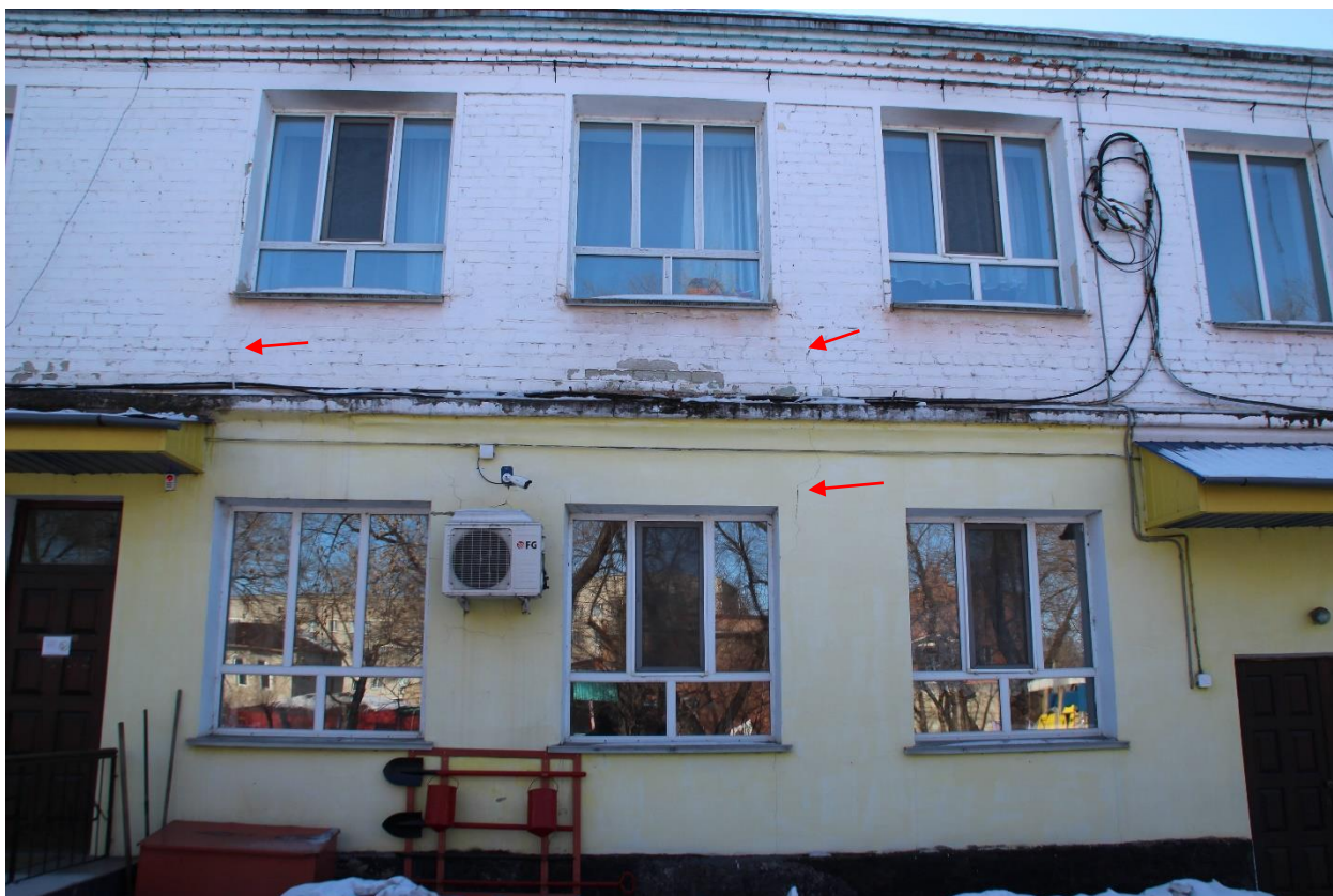
Фото 7. Ось «В». Трещины с раскрытием до 0,5 мм.
